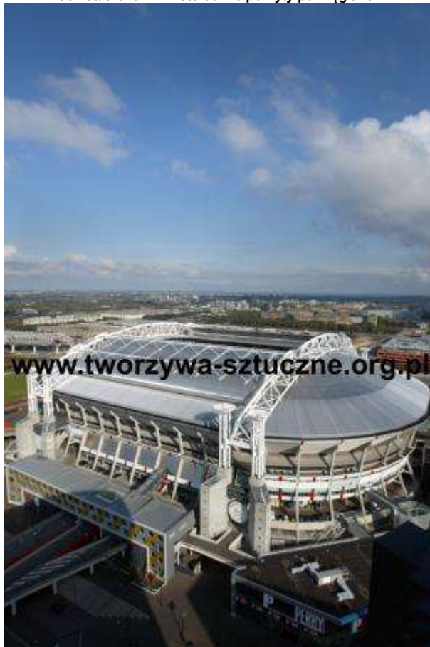
Dach stadionu w Amsterdamie pokryty poliwęglanem.
